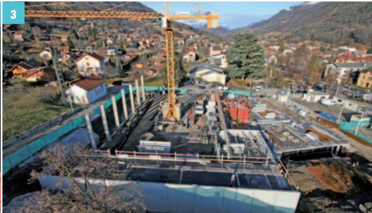
chantier d'envergure. Les dalles du sous-sol ont été coulées, et une première partie de la dalle du rez-de-chaussée a été réalisée. Les murs commencent à être érigés. La pose de la charpente est prévue pour le début du mois de mars. Le 25 janvier dernier, la municipalité a convié les associations à une première réunion de chantier. Nicolas Guillot, l'architecte en charge du projet, a mené la visite et a pu répondre, plans à l'appui, à toutes les questions des membres des associations.
