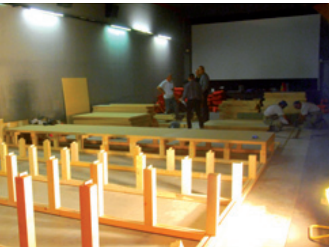
Avec davantage de pente, l'installation du nouveau gradinage permettra une meilleure visibilité
