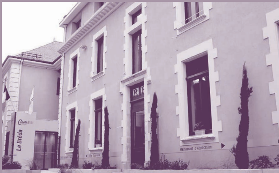
L'installation à Allevard du Lycée Professionnel
