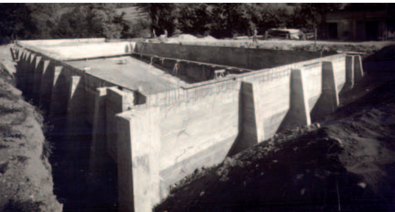
Les travaux de la piscine municipale démarrent en 1950, pour une durée de deux ans
