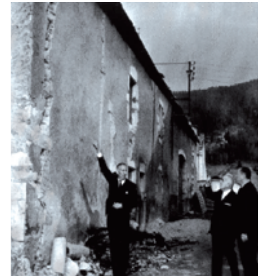
Séisme de Corrençon en 1962 : dégâts sur les habitations
