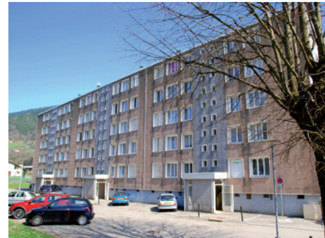
Les travaux de réhabilitation de la résidence "Le David" ont démarré en avril et devraient prendre fin en mai/juin 2014
