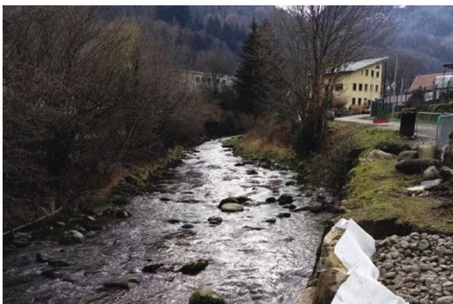
Suite à un effondrement sur une partie de la route et des berges du Bréda, chemin de La Touvière, la commune a procédé à une reprise de l'enrochement de la digue et à la réparation de la route. Au préalable, une demande d'intervention a été réalisée auprès de la Police de l'Eau afin de répondre à la réglementation.
