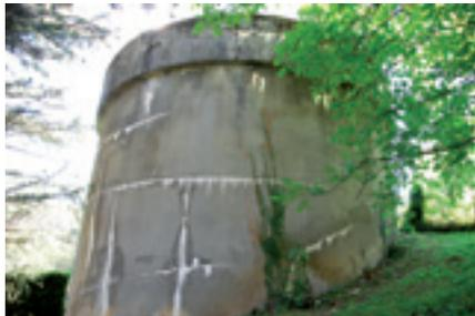
La municipalité d'Allevard a fait réaliser une reprise d'étanchéité sur le réservoir d'eau de 300 m<sup>3</sup>.
